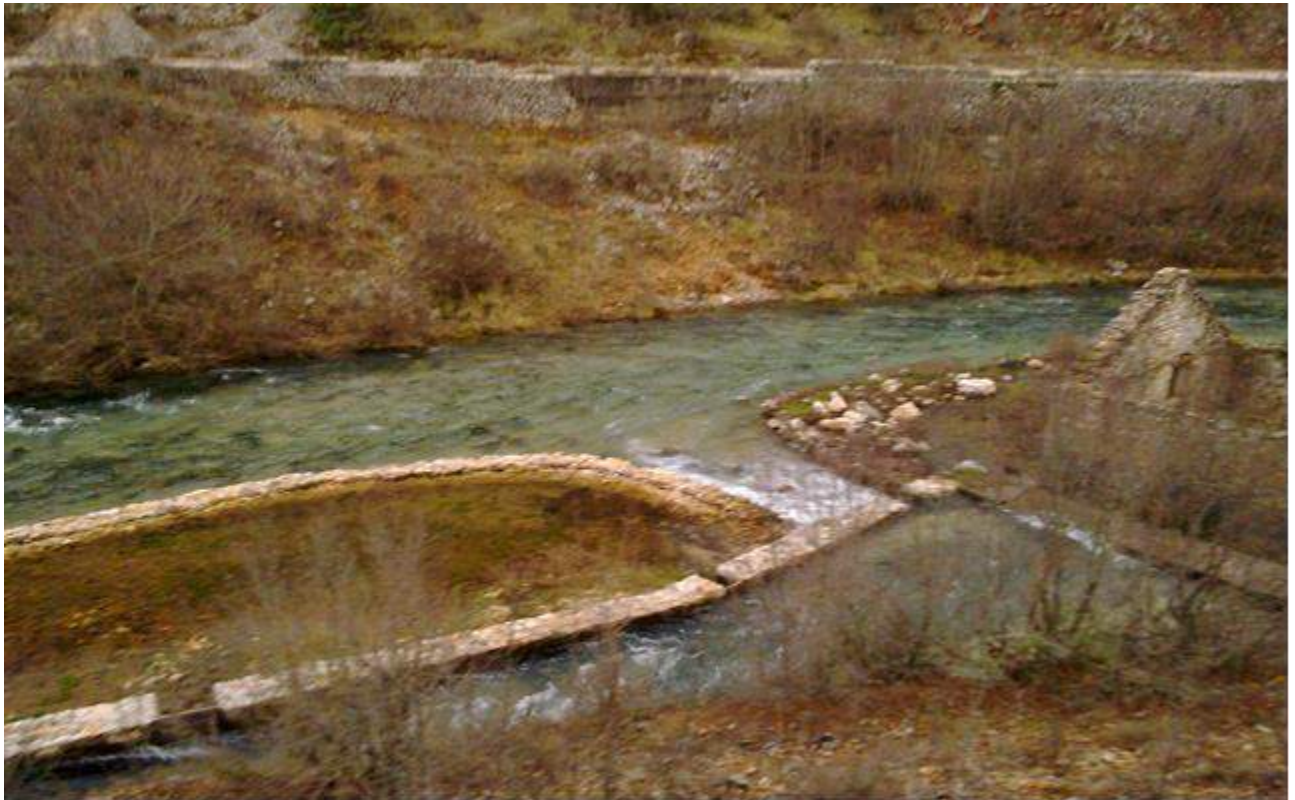
Slika 7.7 Dovodni kanal za mlinicu
