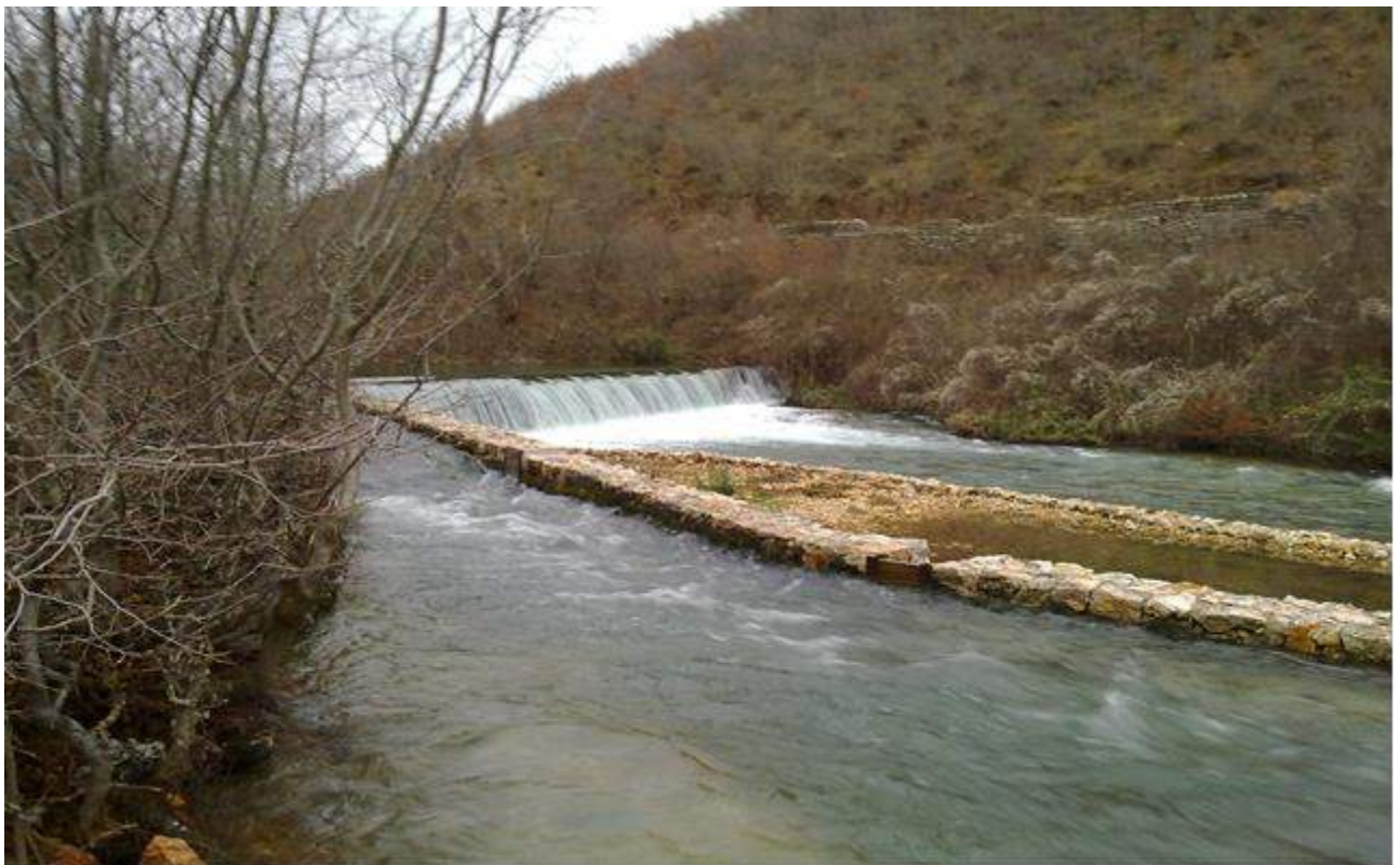
Slika 7.6 Postojeći prag i dovodni kanal
