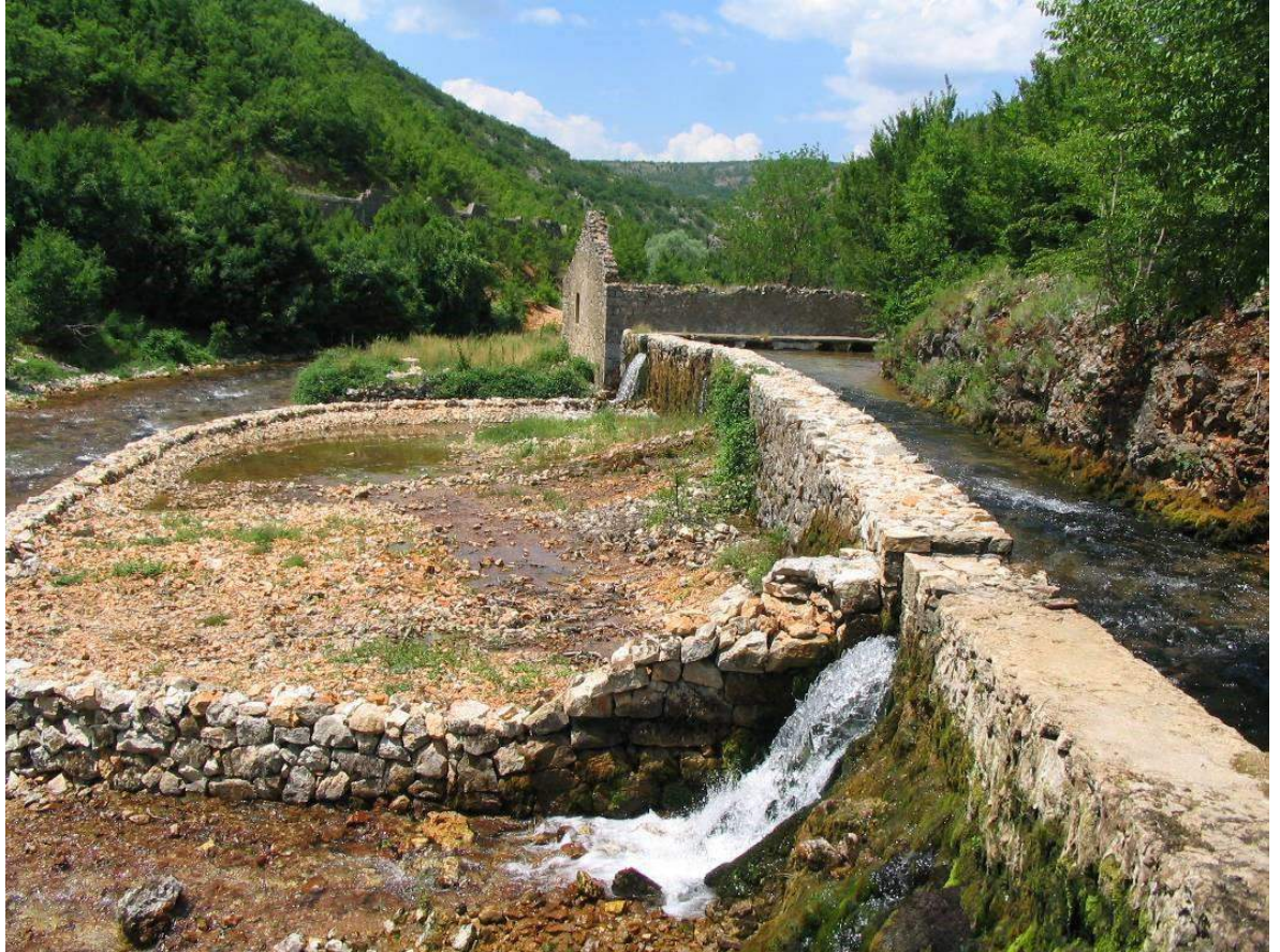
Slika 2.3.4 Pogled na postojeći dovodni kanal koji se rekonstruira
