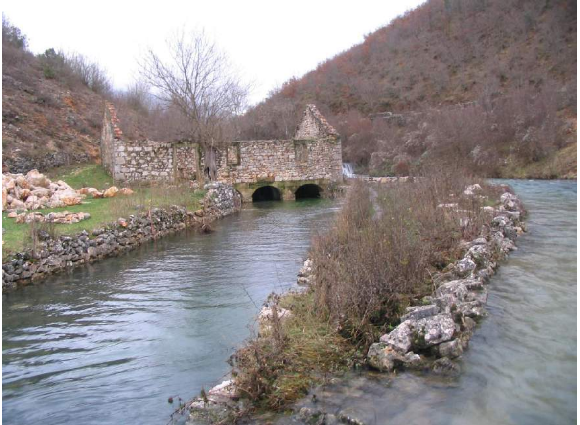
Slika 2.3.5 Pogled na postojeći odvodni kanal koji se rekonstruira
