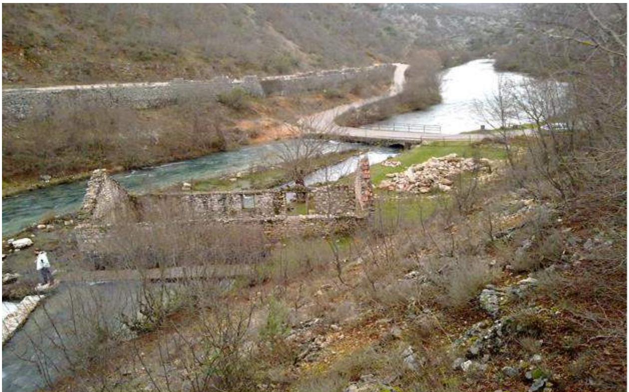
Slika 7.2 Razrušena mlinica koja se obnavlja
