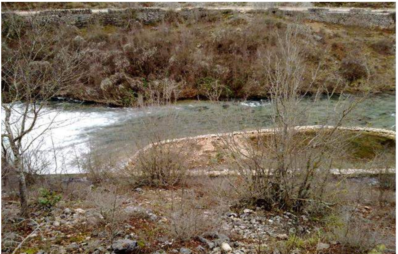
Slika 7.8 Dovodni kanal za mlinicu
