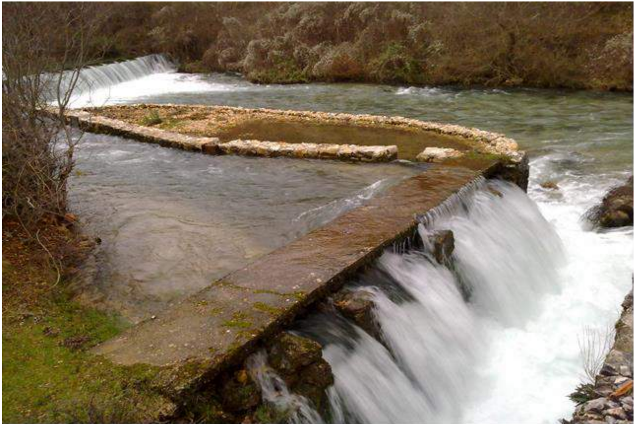
Slika 7.5 Postojeći prag i dovodni kanal
