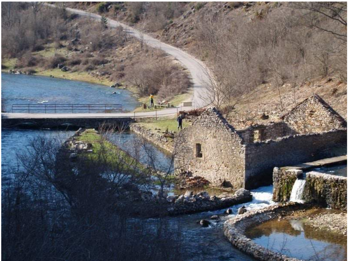
Slika 2.3.2 Pogled na Đurićevu mlinicu koja se rekonstruira
