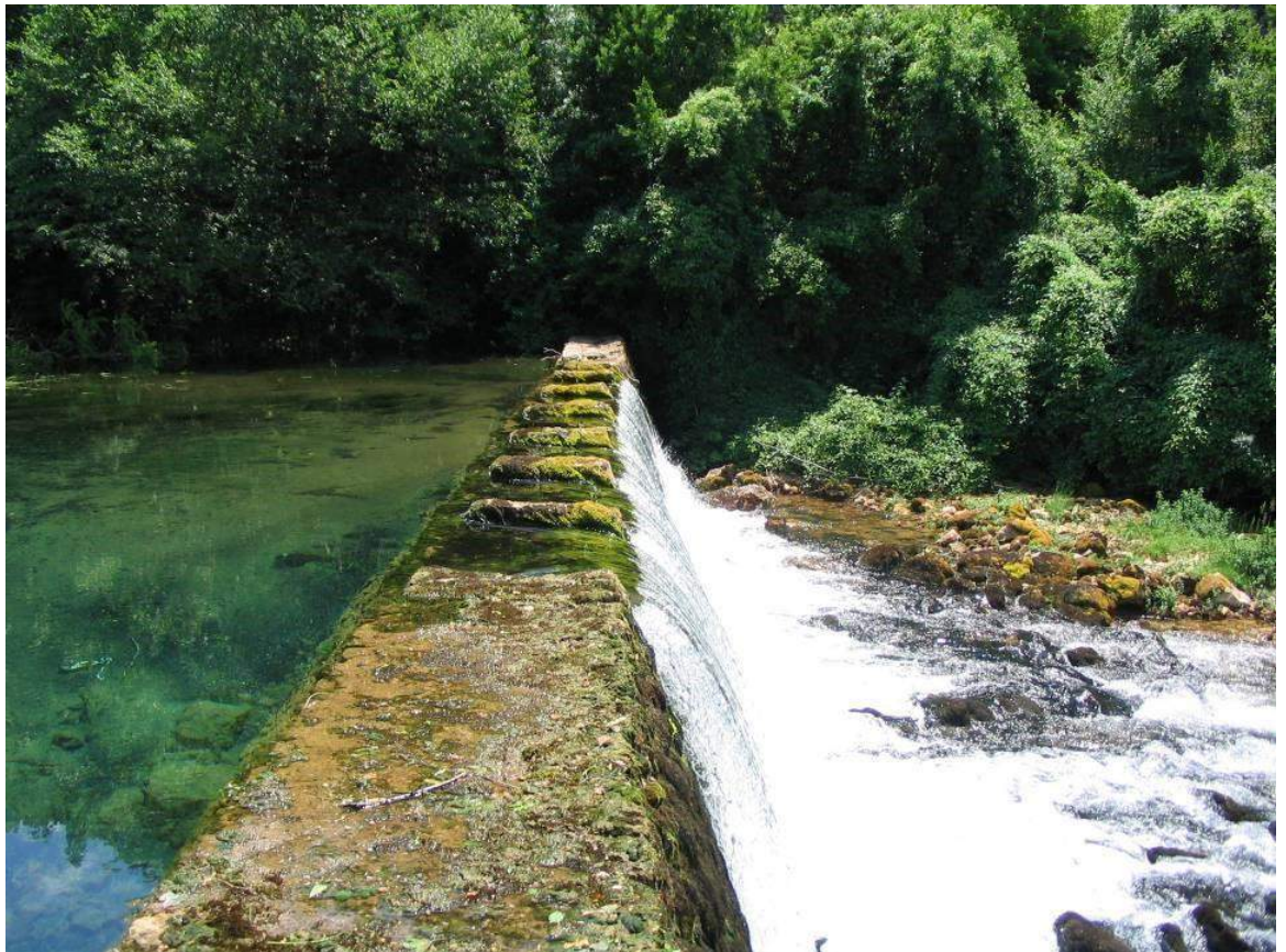
Slika 2.3.3 Pogled na postojeći prag koji se rekonstruira
